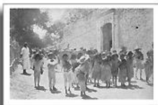
Niños con materiales para la construcción de la Escuela Federal de Hidalgo, en las Misiones Culturales 1927. p. 125.
